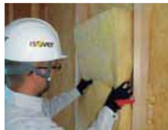
**グラスウールなら** 軽量で柔らかい材質で、施工しやすい断熱材です。短期間で施工できるので、建築の省コスト化にも貢献します。
