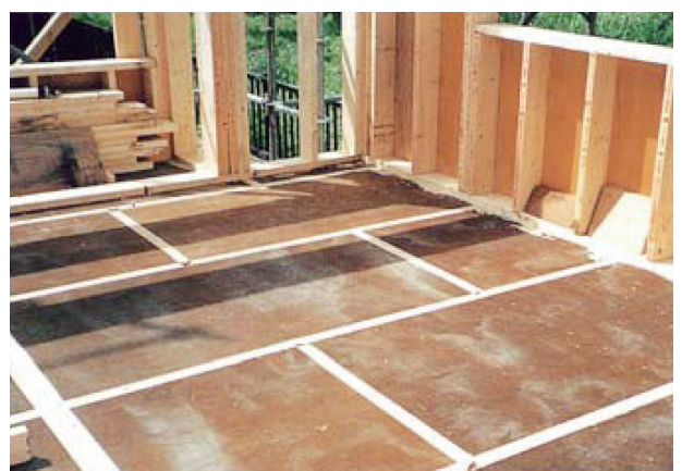
▼床合板の目地処理の施工
