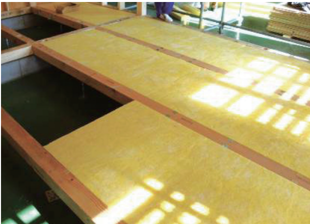
▼土台・大引間の断熱材の施工
