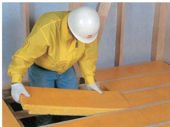
▼根太間の断熱材の施工
