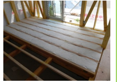
根太床の施工例
