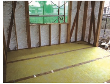
剛床(根太レス)の施工例
