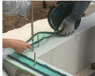
アンカーがある場合はカッターで切れ目を入れて通します。
