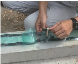
継ぎ目はパッキン部分が繋がるように重ねます。
