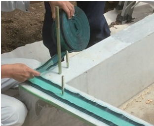
基礎上面にノルシール土台気密パッキンを敷きます。
