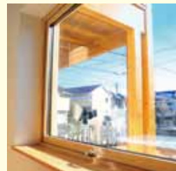
3層ガラス、 木製サッシ (Low-E) U値:0.7W/m 2 K
