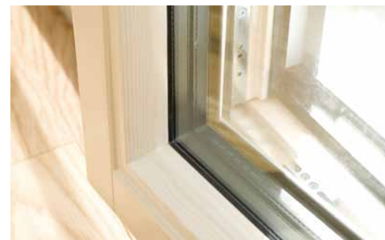
木製3層ガラスの高性能サッシを採用
